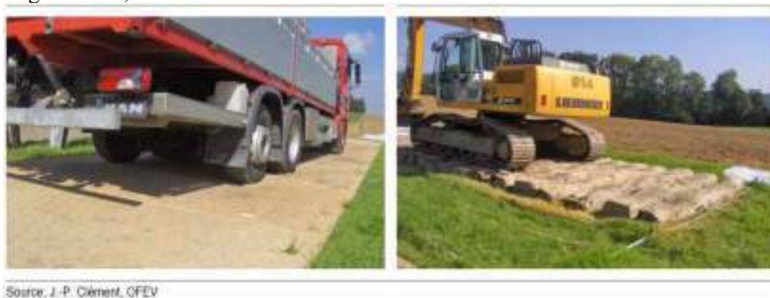
Figure 5.29 : Pistes en plaques (à gauche) ou en rondins de bois (à droite). Extrait du Manuel Sols & Constructions (OFEV, 2015)
